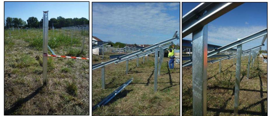
Illustration 26 : Montage des structures porteuses sur la centrale photovoltaïque de Salbris – Loir-et-Cher (Source : EREA Ingénierie)
